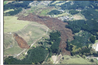
2.勾配の緩い斜面でも斜面崩壊や地すべりが発生
