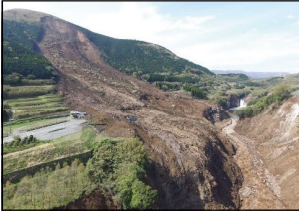
1.大規模な斜面崩壊が発生
